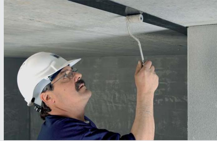
Klebebewehrung: Verstärkung bestehender Decken mit Carbonfaserlamellen
