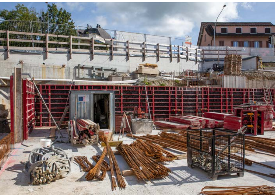
Armieren und betonieren mit den eigenen Schalungen
