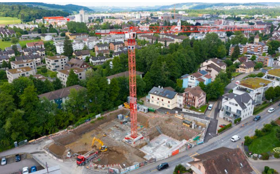
Baubeginn mit Baugrube, Bodenplatte und Kraninstallation
